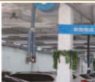
為了提供安全的作業環境，在車間建設之初，配備全套尾排收集系統，在車輛維修過程中產生的尾氣，通過尾系統收集排放，確保車間環境清潔不受有害氣體侵蝕。
